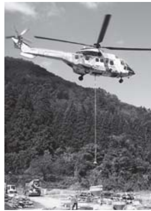
鉄塔工事のため生コンの入ったバケツを運ぶヘリ
