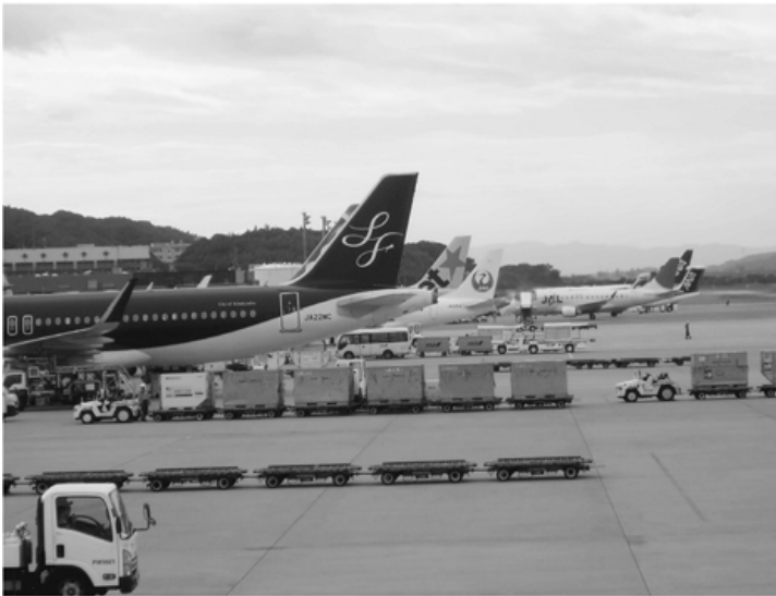
2015年の空港利用者が2000万人を超え、空港拡張工事が進む福岡空港
